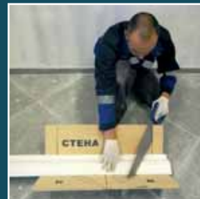
Монтаж лепного декора
