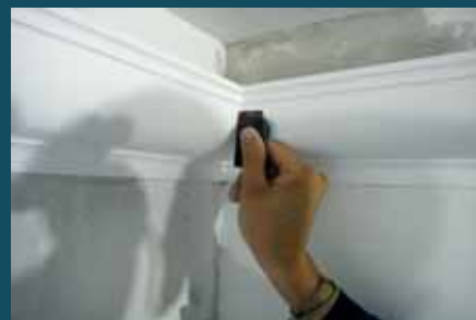
10. Зачистите место стыка наждачной бумагой и зашпаклюйте дырки от гвоздиков и степлера
