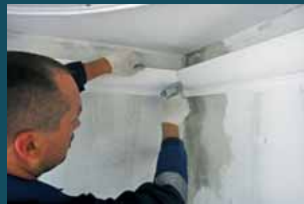
7. Место стыка зафиксируйте строительным степлером
