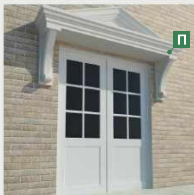
Подоконник в составе дверного обрамления
